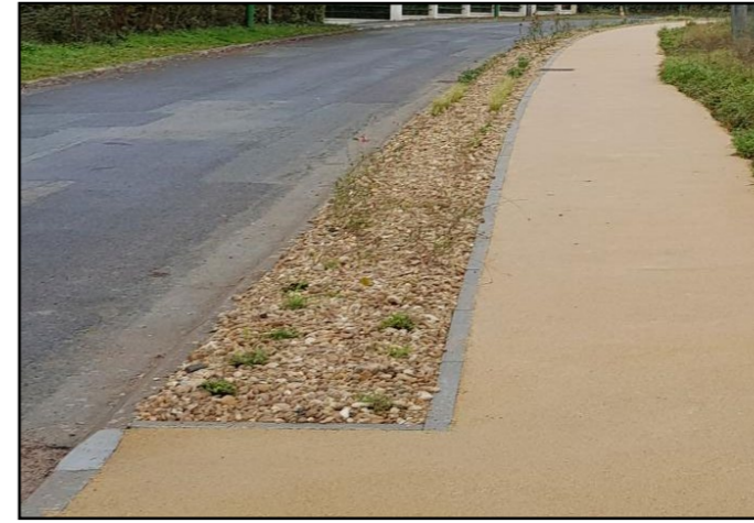
Trottoir et cheminement finition enrobé beige
